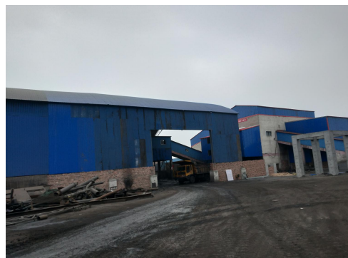
图 2 项目南侧 精煤棚
