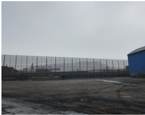
图5 项目厂址现状
