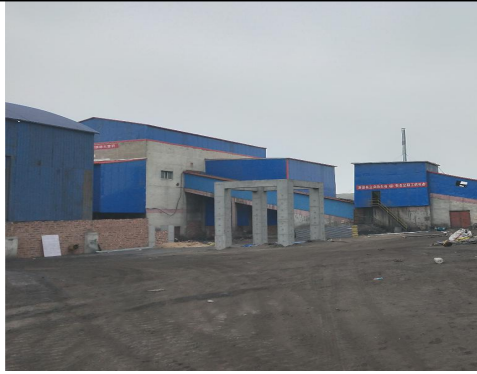
图3 项目西侧 洗选生产线
