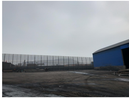
图4 项目北侧 旺昊砖厂
