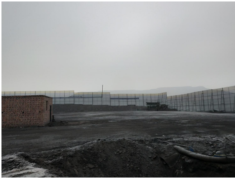
图 1 项目东侧 通州煤矿
