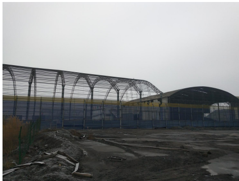
图 3 项目西侧 源鑫洗煤厂
