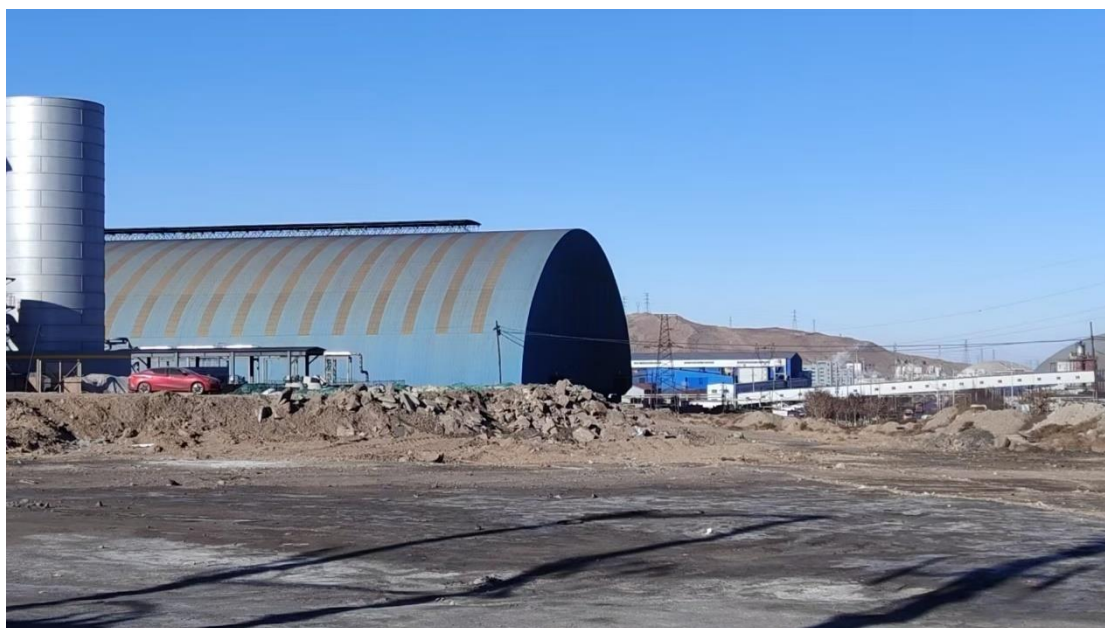
厂区北侧（内蒙古美方煤焦化有限公司一洗煤）
