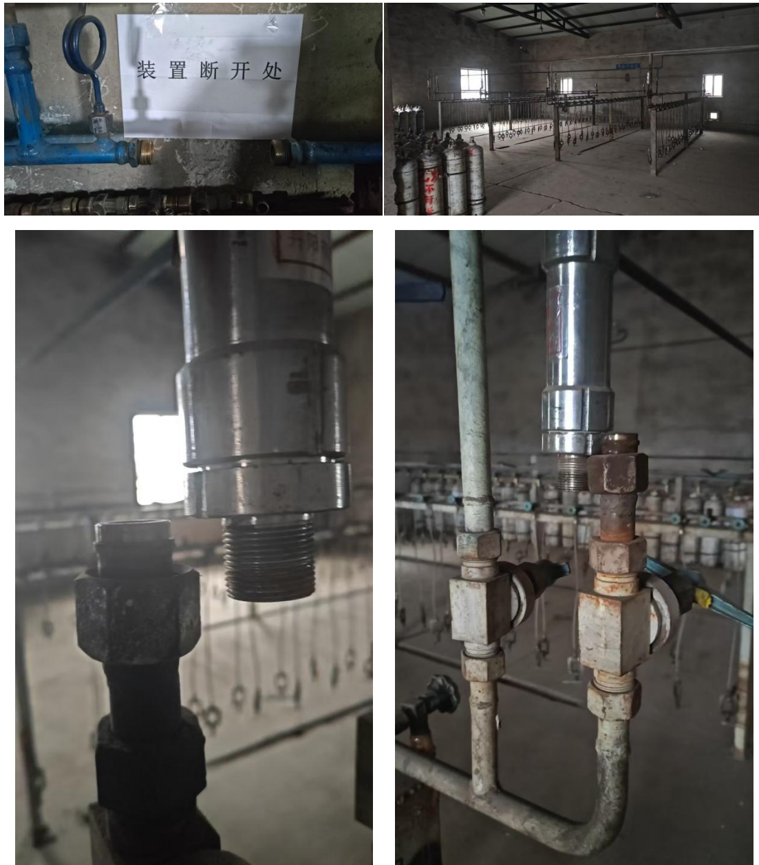
图3.6-1 现有工程现状
