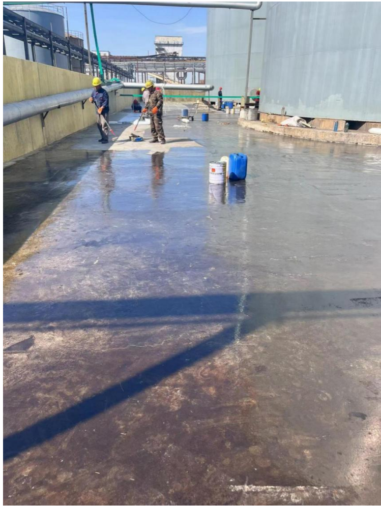
罐区环氧树脂防渗层照片
